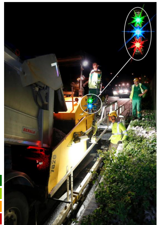
Finisseur équipé d'un mini LumiTube
